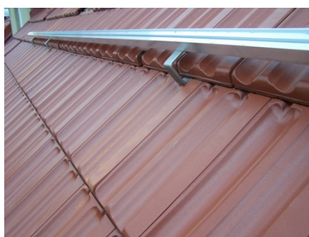
Abb. 3b Querprofile auf dem Dachhaken
